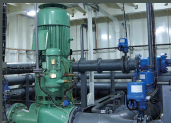
Prüfung an verbauten, spannungslosen Motoren
